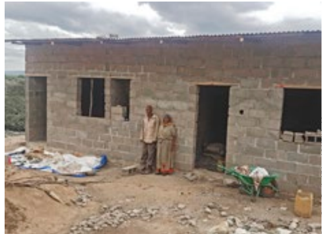
2019 entstehen in Äthiopien mithilfe der Ausschüttung der Stiftung neue Häuser und sanitäre Einrichtungen für bedürftige Familien.
