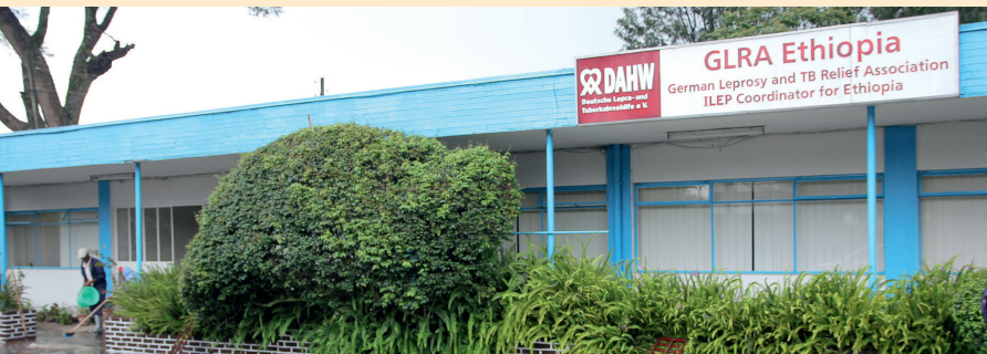
DAHW-Verwaltungsgebäude in Bisidimo
