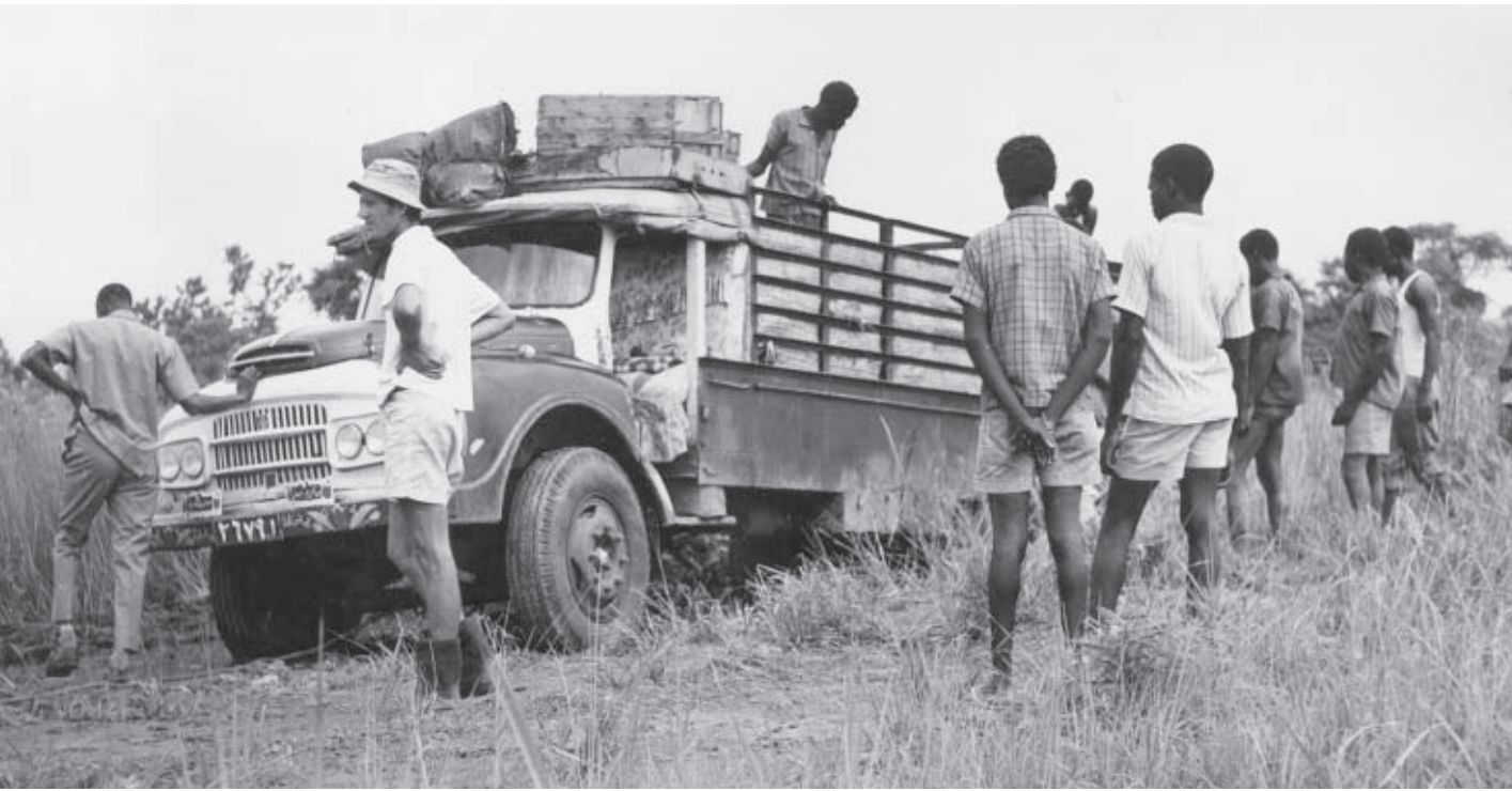
Bautransport nach Wau-Agok, Sudan
