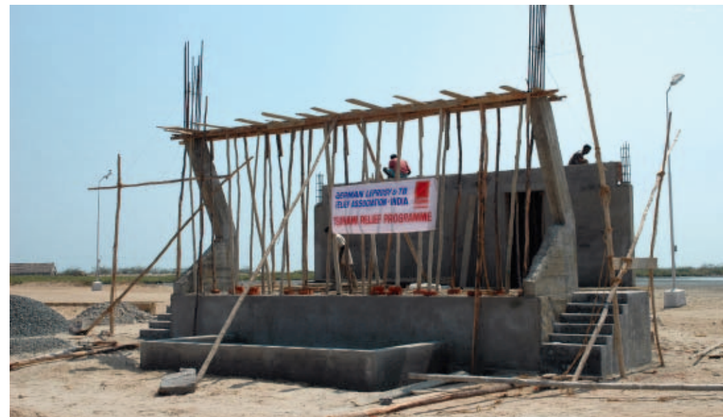
Hausbau nach Tsunami in Südindien
